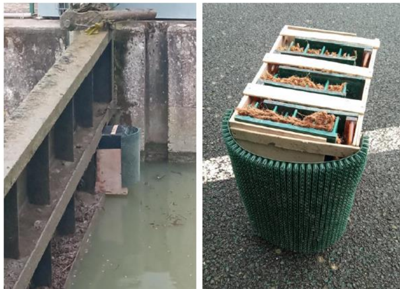
Figure 61 : Présentation de l'équipement complémentaire (« boîte » en version avec plots et support en fibres de coco) et de son implantation sur la lumière
