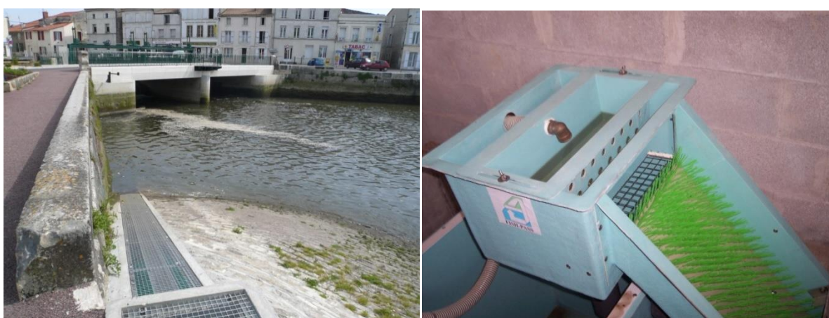
Figure 56: Photos de la passe piège anguilles de Saujon (brosse extérieure sous grille et piège)
