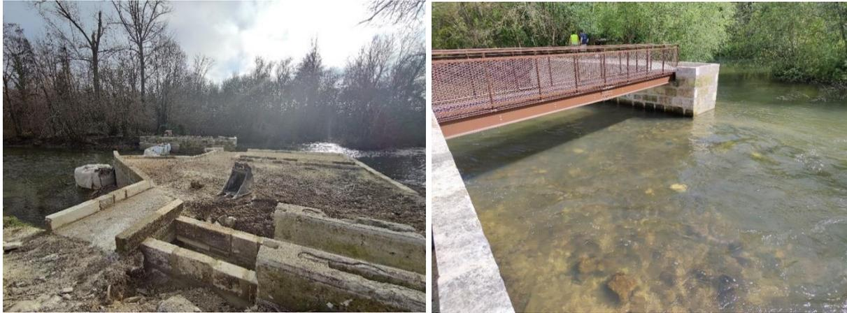
Figure 10 : Photos des travaux à St Simon (à gauche : Continuité écologique rétablie et valorisation patrimoniale (27/01/2022), à droite : Passerelle installée à Saint-Simon au-dessus du radier construit suite à la déconstruction d'anciens passages d'eau (14/04/2022))
