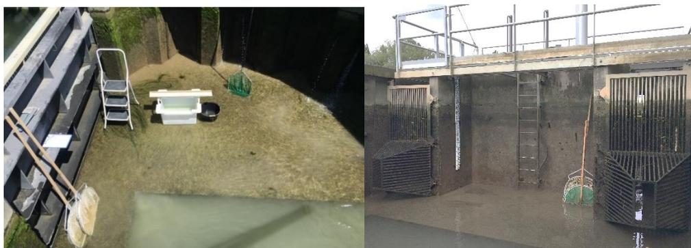
Figure 34 : Grilles entonnoirs et matériels de biométrie
