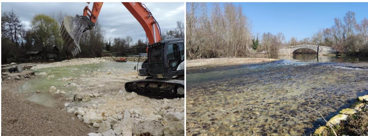
Figure 9 : Photos des travaux sur Vibrac (à gauche : Construction du radier amont de Vibrac (11/03/2022), à droite : Radier amont de Vibrac (09/02/2023))
