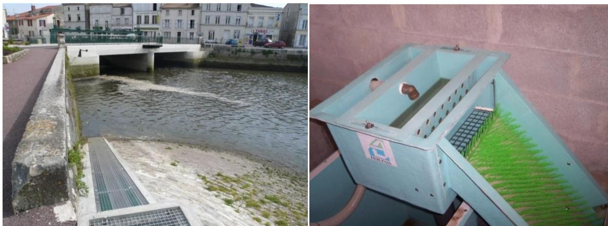
Figure 66: Photos de la passe piège anguilles de Saujon (brosse extérieure sous grille et piège)
