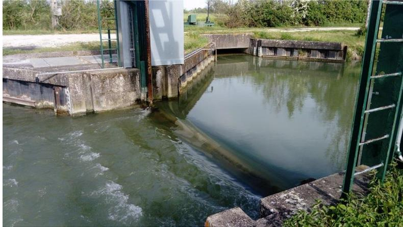
Figure 72 : Vanne de Suze baissée et surverse
