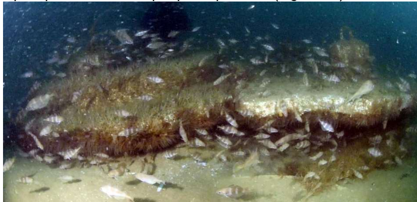
Figure 15 : Récif CREEA altéré d'un demi-étage et de ses deux plaques supérieures
