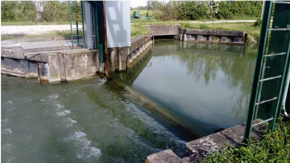
Figure 40 : Vanne de Suze baissée et surverse
