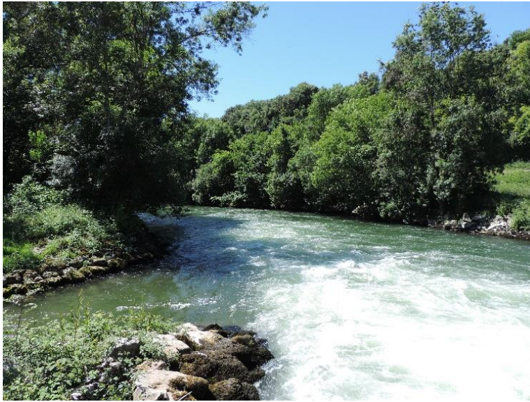
Figure 92 : Bagnolet le 27/05/20. Le clapet rive gauche et la vanne wagon laissent passer l'eau. L'attractivité de la passe en rive gauche serait maximisée si le clapet rive gauche était davantage relevé et le clapet rive droite abaissé et laissant passer le flux hydraulique en majorité.
